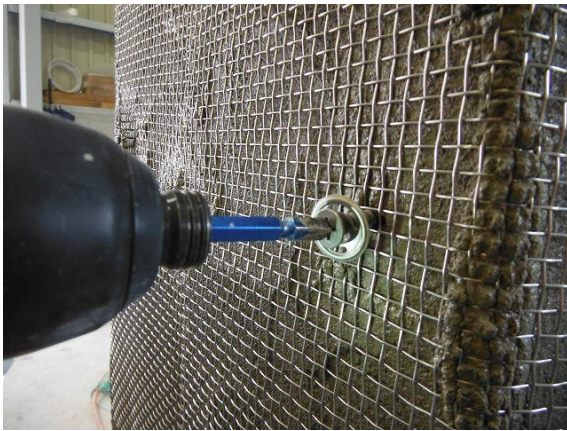
アンカーピンの取り付け
