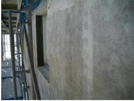
<写真⑩>養生の状況
