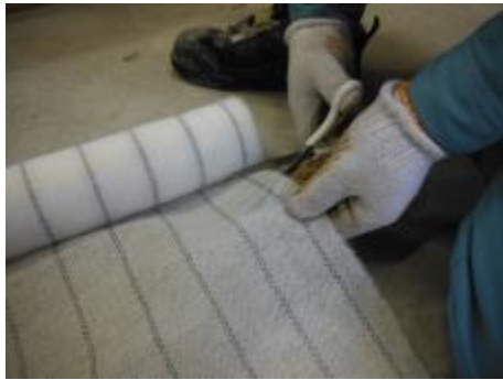
<写真②>ネットの切断（ハサミ）
