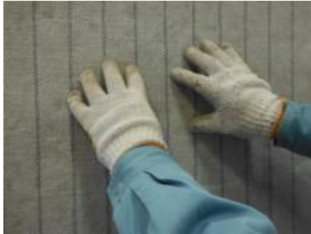
<写真⑧>ネットの仮固定
