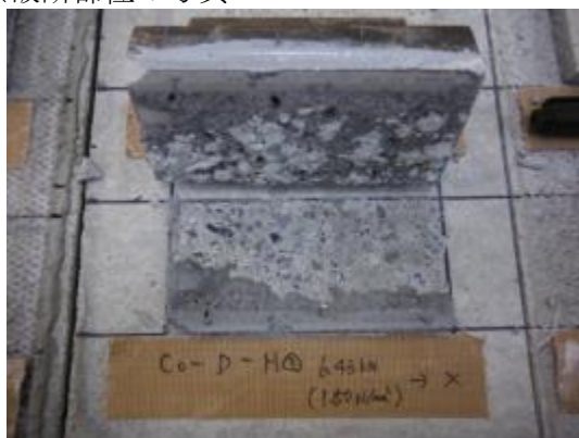
コンクリート直張り
