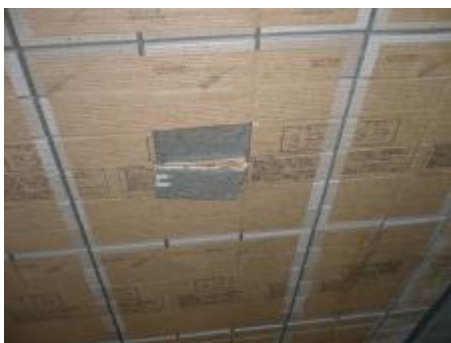
<写真⑲>タイルモルタルの充填確認
