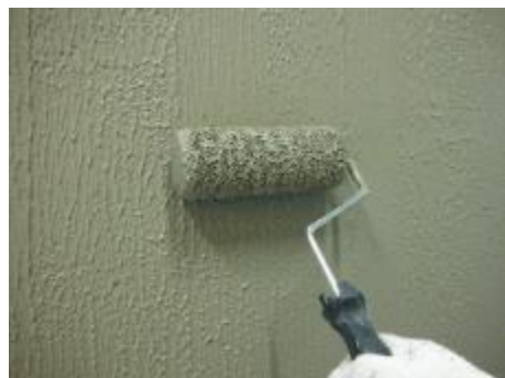
＜写真⑦＞マスチックローラー使用
