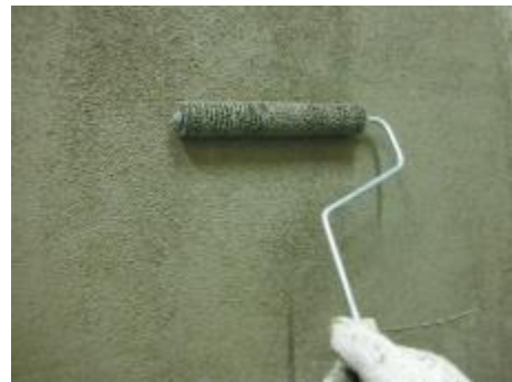
<写真⑭>不良箇所の補修（押え）
