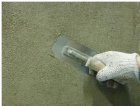
<写真⑬>不良箇所の補修（塗り付け）
