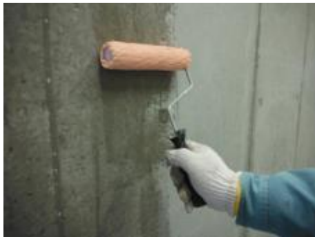
<写真①> 吸水調整材塗布状況
