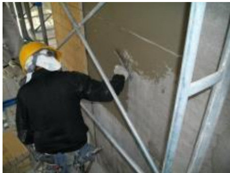
<写真⑰>タイル張付材塗り付け
