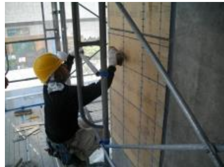
<写真⑱>タイル圧着張り
