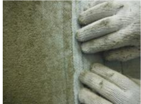
<写真⑨>ジョイント部の状況
