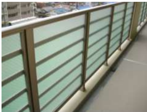
アルミ手摺の支柱を固定
