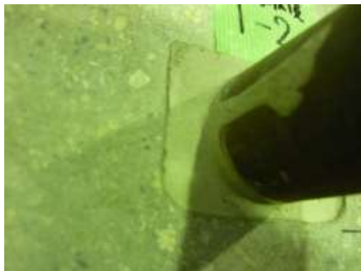
ひび割れ発生無 写真 9.5 「ファイバースタウト」除荷後の状況
