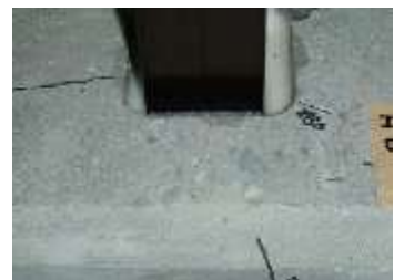
「エポキシ樹脂系グラウト」 写真 12.5 除荷後の状況
