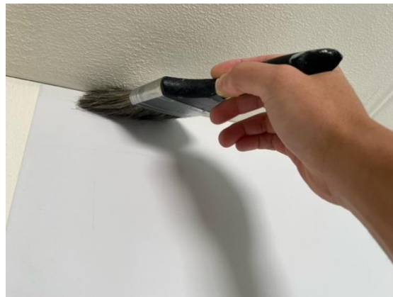
写真5. ラスター刷毛による入隅圧着
