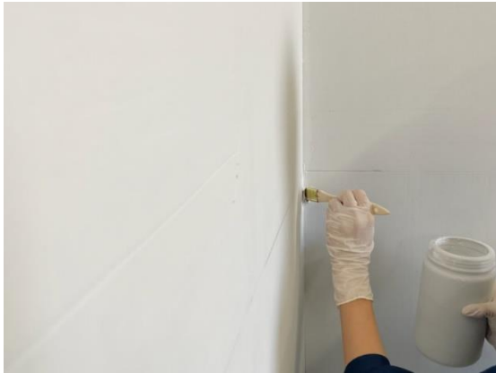
写真8. 入隅パテ処理
