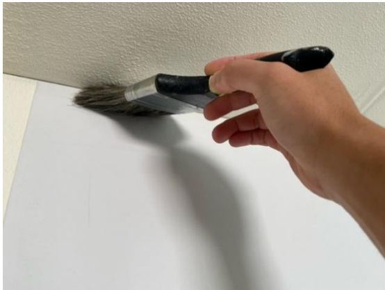
写真7. ラスター刷毛による入隅圧着
