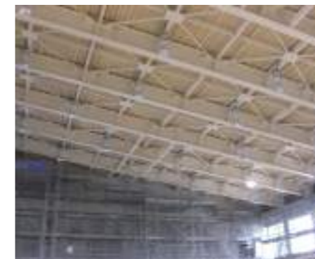
体育館 鉄骨梁
