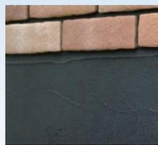
施工面全体に接着剤を塗り付けて、エコタイルを貼り付けます。(接着剤が目地となります)
